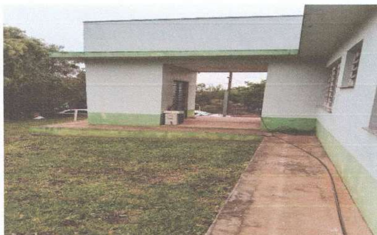
Figura 17: Local onde será feito ampliação do prédio
