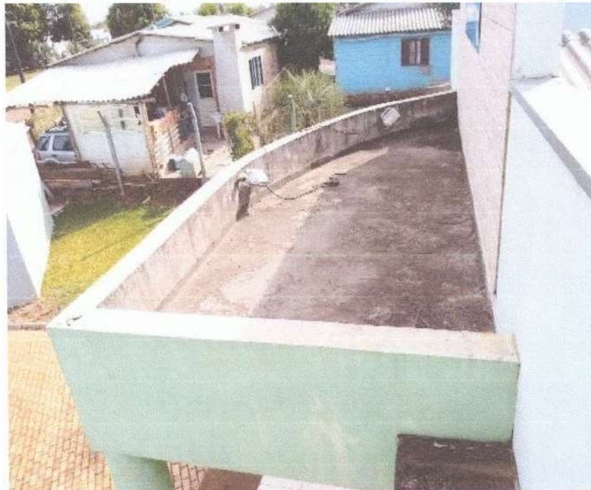
Figura 6: Laje fachada impermeabilizar, regularizar contrapiso da laje e inclinação.
