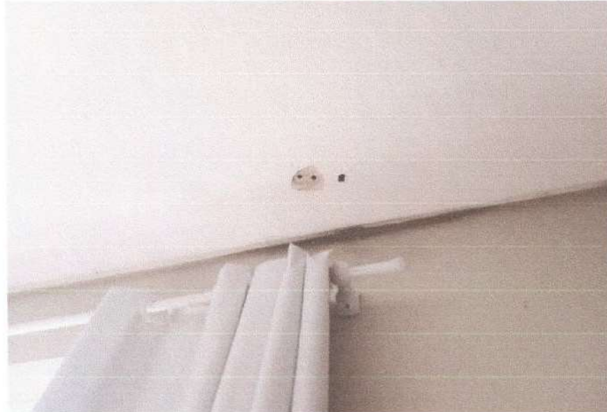
Figura 5: Forro de Gesso - Auditório
