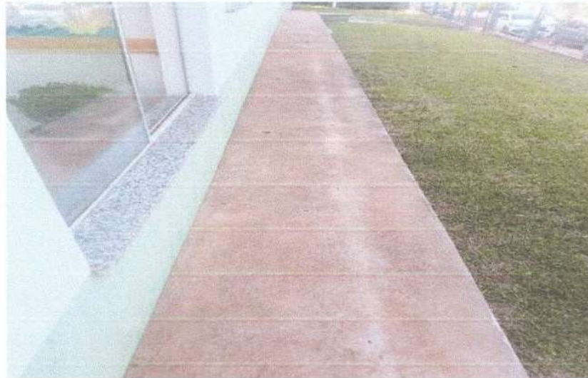
Figura 19: Contrapiso a ser revestido com cerâmica
