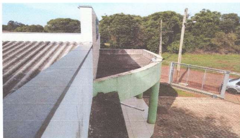
Figura 18: Cano a ser canalizado no pilar arquitetônico.
