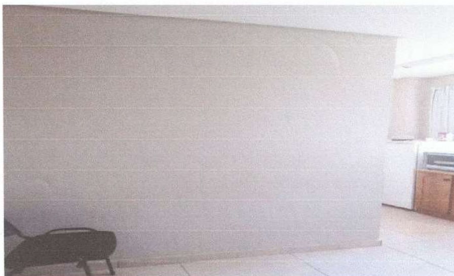
Figura 14: Paredes banheiro a ser removidas
