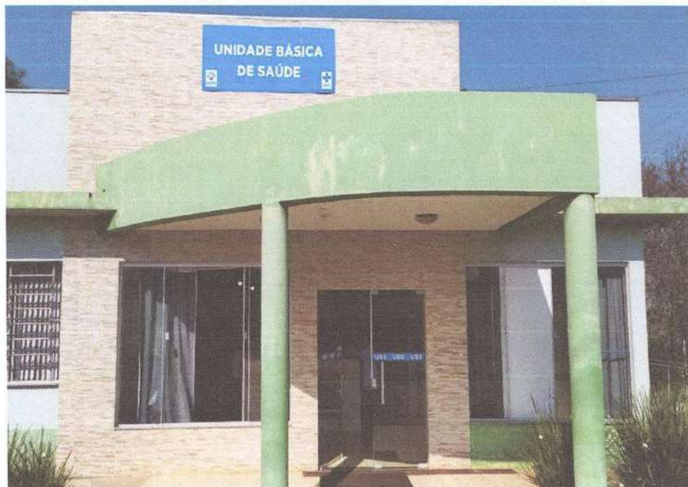
Figura 01: Posto a ser reformado.
