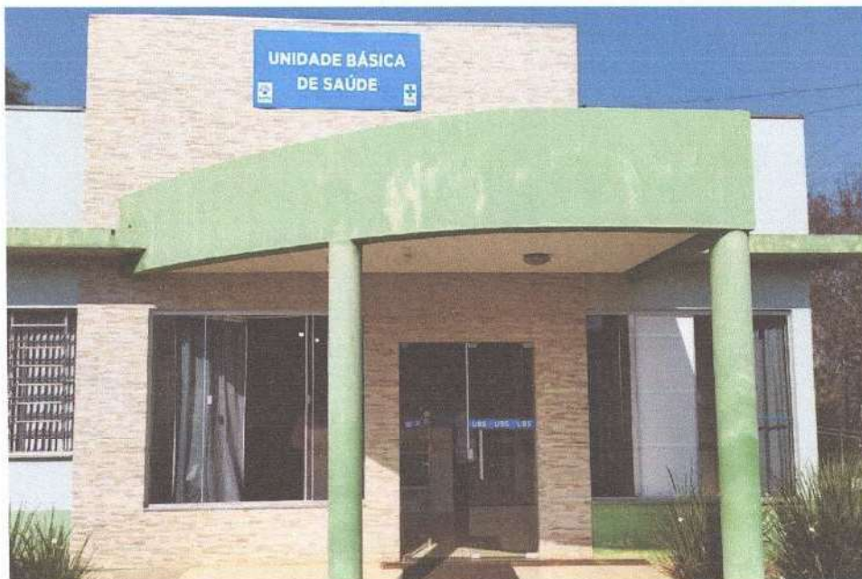
Figura 8: Revestimento em cerâmica a ser retirado
