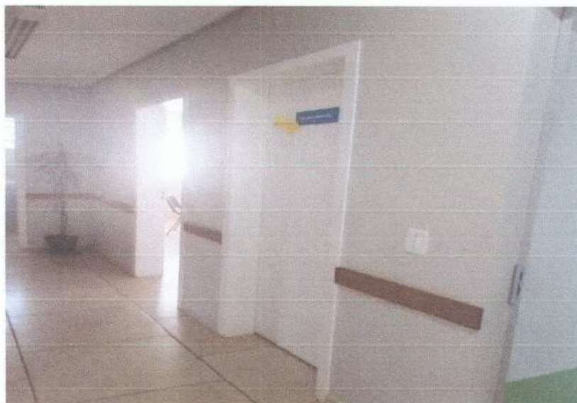
Figura 13: Entrada Almojarifado - Fechamento porta
