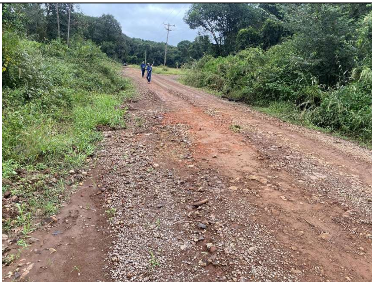
Imagem: Local a ser implantada a substituição da tubulação existente, compreendendo a travessia e direcionamento até rio próximo, além de execução de sub-base e base para recomposição da pista, no trecho 02 da Comunidade Santa Terezinha.
