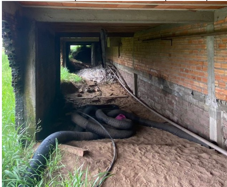
Túnel de serviço a ser pavimentado com piso de concreto
