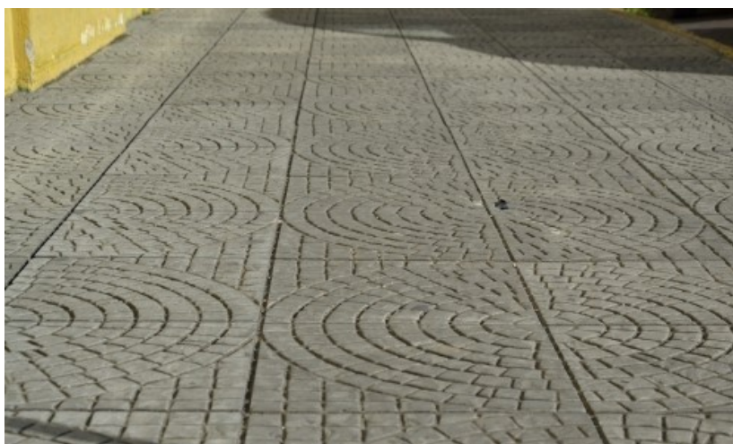
Aspecto final da pavimentação com lajotas de concreto decoradas
