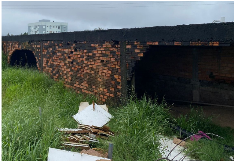
Detalhe das alvenarias a serem reconstruídas
