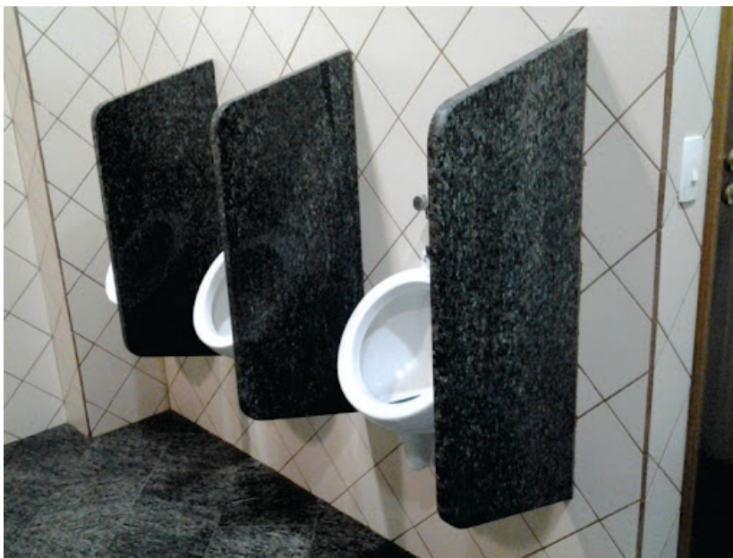
Exemplo de divisória de granito para mictório
