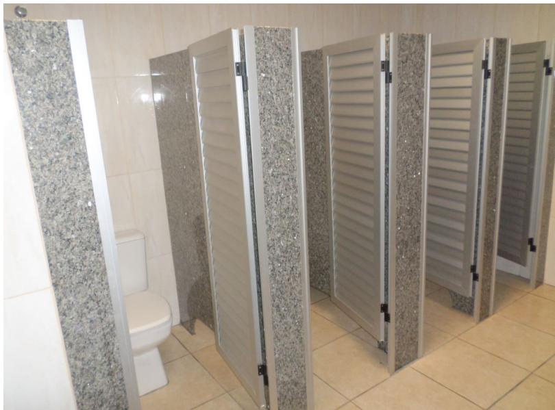
Exemplo de divisória de granito com portas de alumínio
