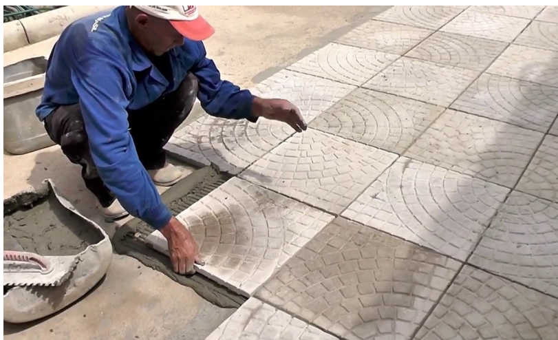
Assentamento de lajotas de concreto decoradas
