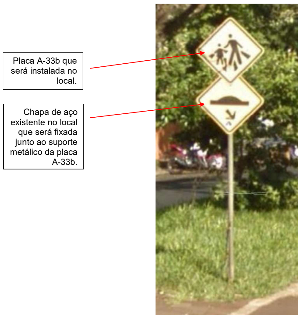
Figura 04 – Placa A-33b + A18 que será instalada entre a Rua Tiradentes e Marquês do Tamandaré.
