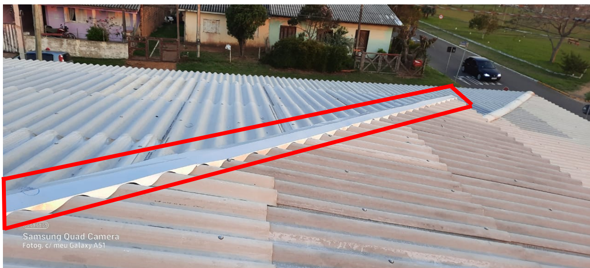
Exemplo de espigão metálico a ser instalado em todos os encontros de águas do telhado
