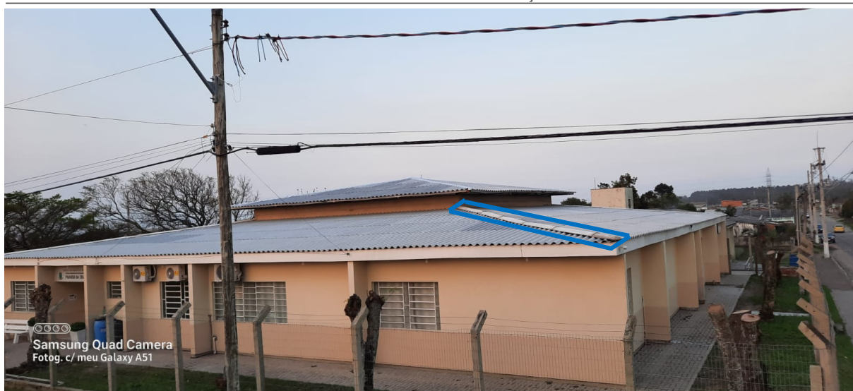
Espigões de fibrocimento a serem substituídos
