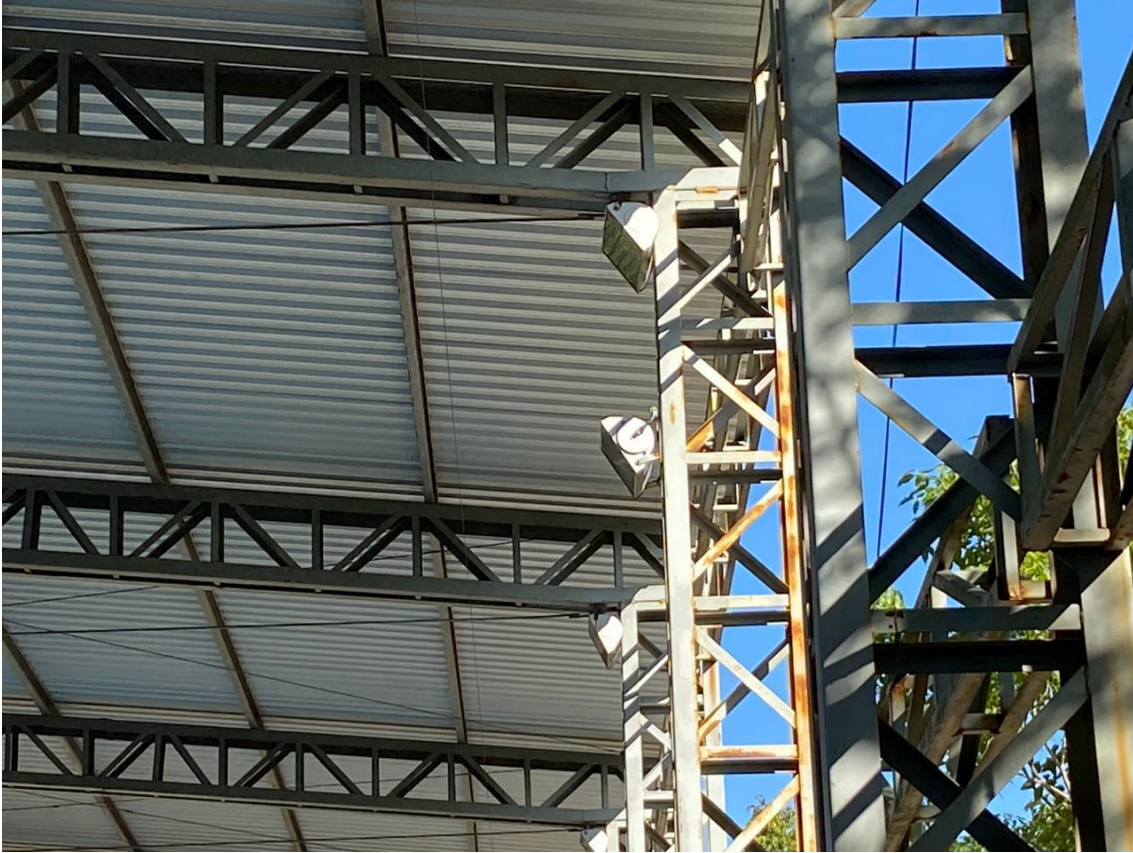
Imagem 06: Estrutura cobertura ginásio escola.
