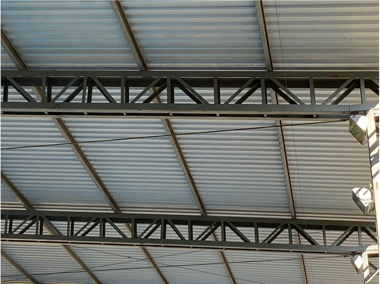
Imagem 05: Estrutura cobertura ginásio escola.
