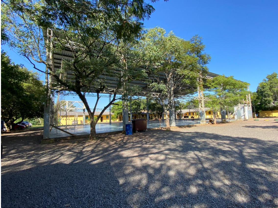
Imagem 01: Fachada do ginásio que será instalado as placas fotovoltaicas.
