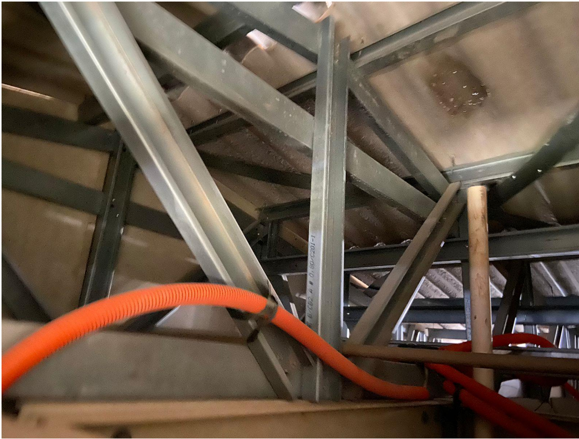
Imagem 07: Estrutura cobertura telhado.
