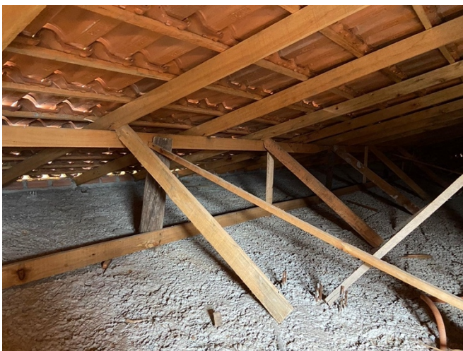
Imagem 05: Estrutura existente da cobertura do telhado.
