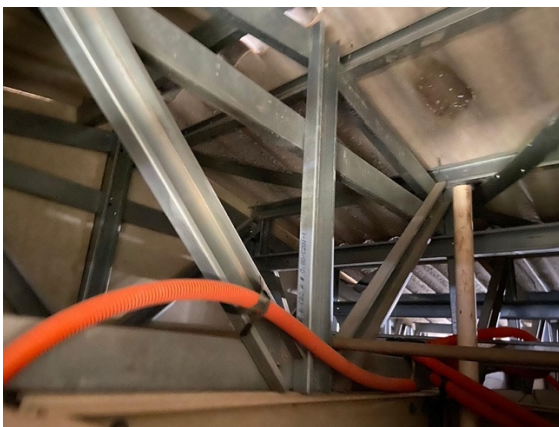
Imagem 07: Estrutura cobertura telhado.
