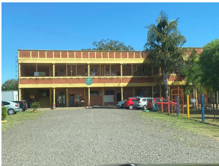
Imagem 01: Fachada da escola.
