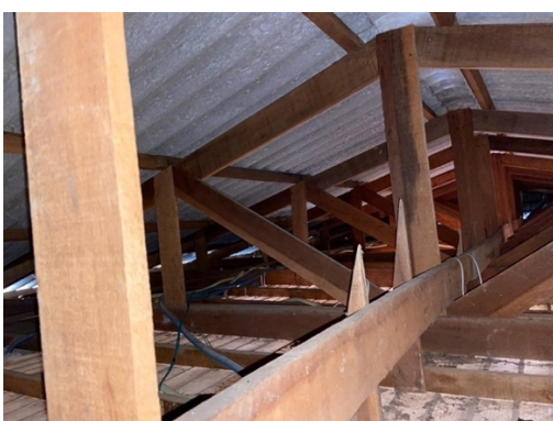
Imagem 08: Estrutura existente cobertura prédio 2.
