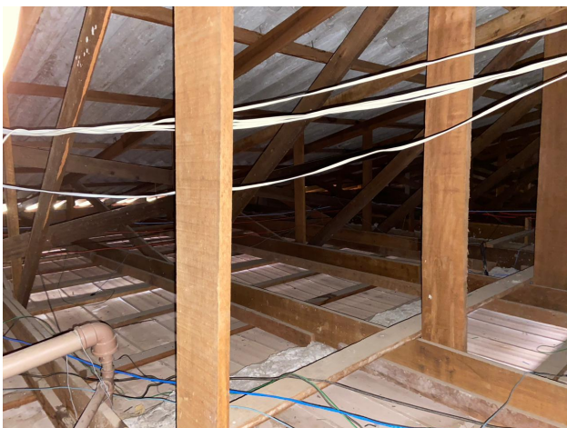
Imagem 06: Estrutura existente cobertura prédio 1.
