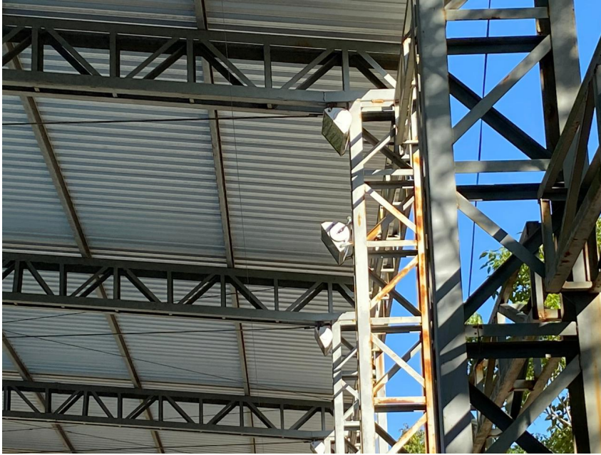
Imagem 06: Estrutura cobertura ginásio escola.
