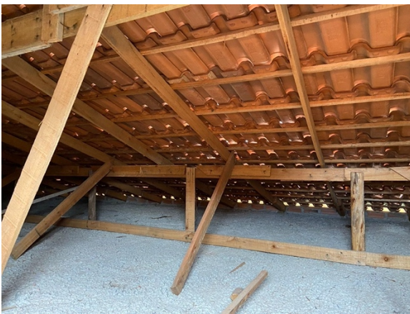
Imagem 03: Estrutura existente da cobertura do telhado.
