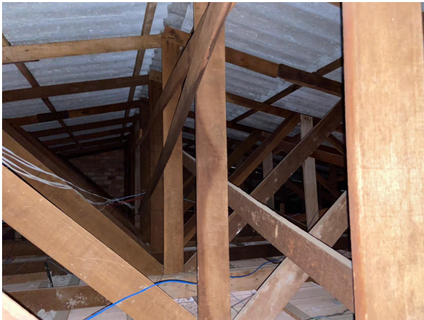
Imagem 05: Estrutura existente cobertura prédio 1.
