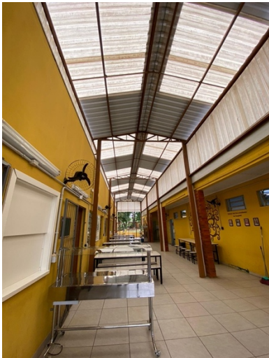
Imagem 08: Estrutura existente da cobertura do prédio 2.
