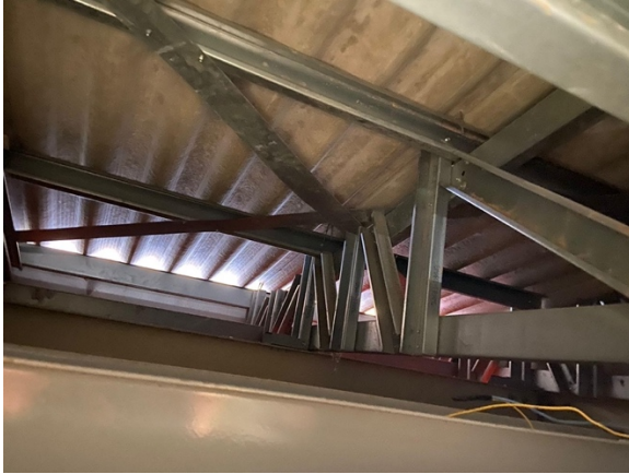
Imagem 08: Estrutura cobertura telhado.
