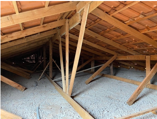
Imagem 04: Estrutura existente da cobertura do telhado.
