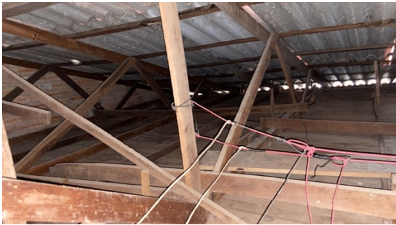
Imagem 07: Estrutura existente da cobertura do prédio 1.
