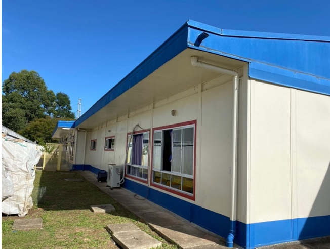
Imagem 03: Fachada prédio 3 e 4.
