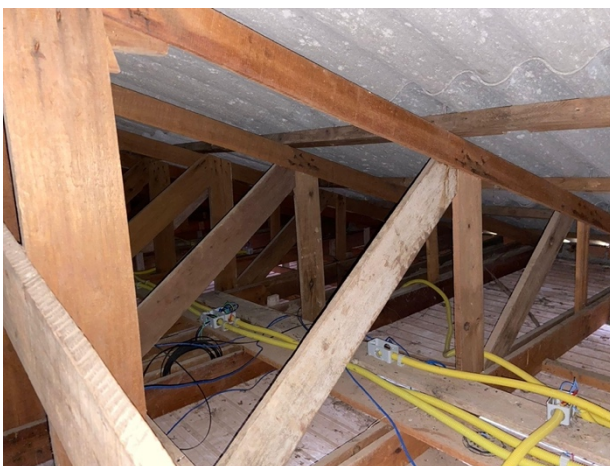
Imagem 09: Estrutura existente da cobertura do prédio 3.
