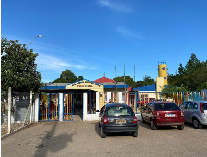
Imagem 01: Fachada da escola.
