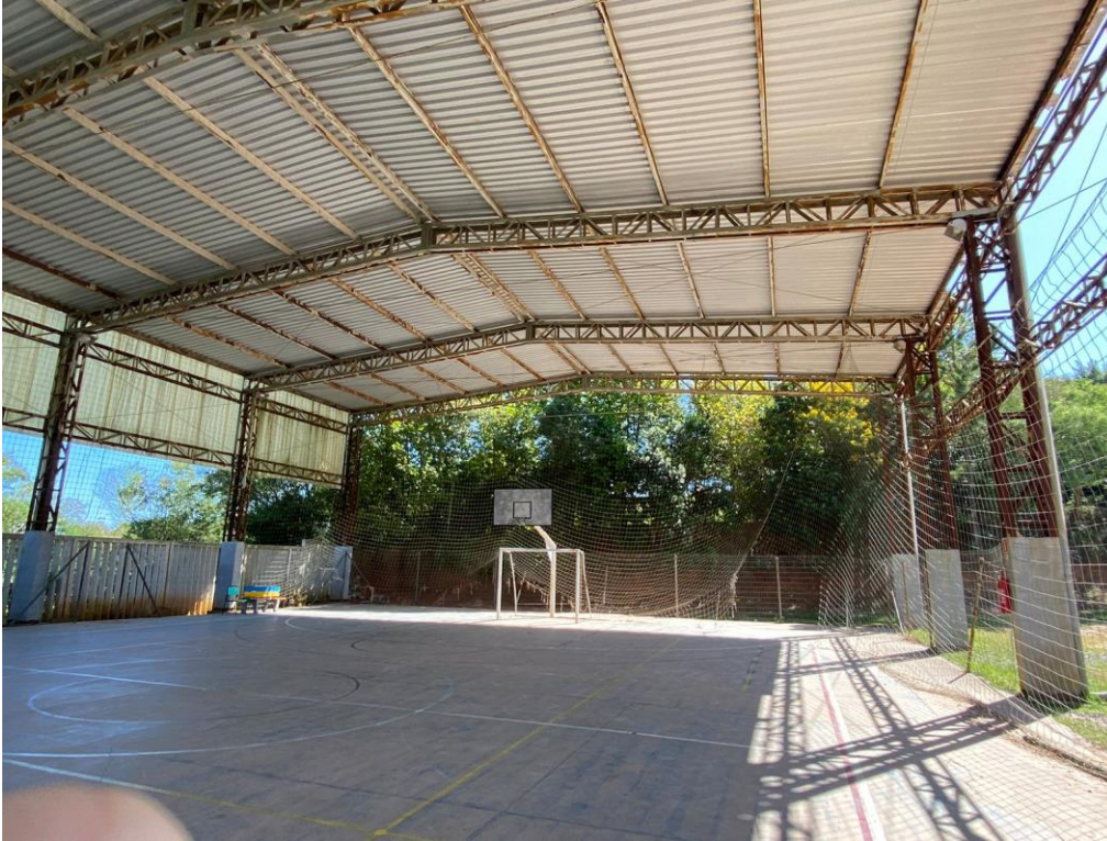
Imagem 05: Estrutura ginásio escola.
