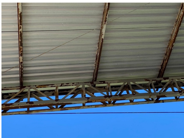
Imagem 06: Estrutura cobertura ginásio escola.
