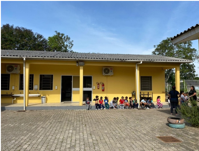
Imagem 03: Fachada do prédio 3 da escola que será instalado as placas fotovoltaicas.
