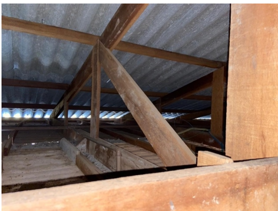
Imagem 07: Estrutura existente cobertura prédio 2.
