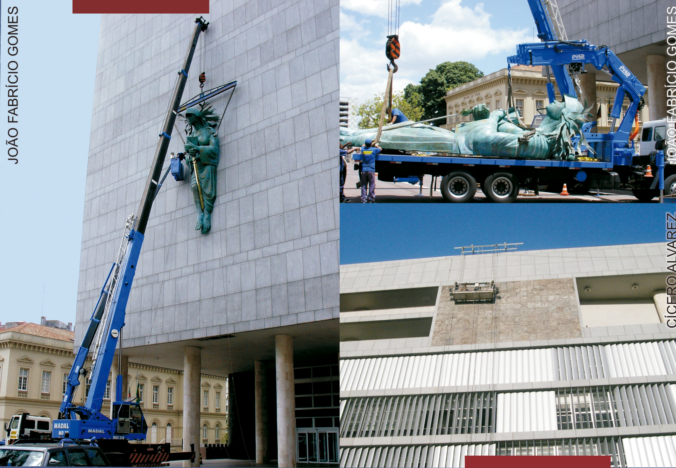
Março de 2004: colocação das placas de concreto que compõem os murais em relevo; representam, a leste, riquezas naturais do Rio Grande do Sul – fauna, flora e relevo - e, a oeste, povo, história e cultura rio-grandenses.
