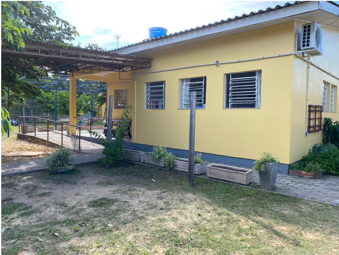
Imagem 01: Fachada do prédio 1 da escola que será instalado as placas fotovoltaicas.
