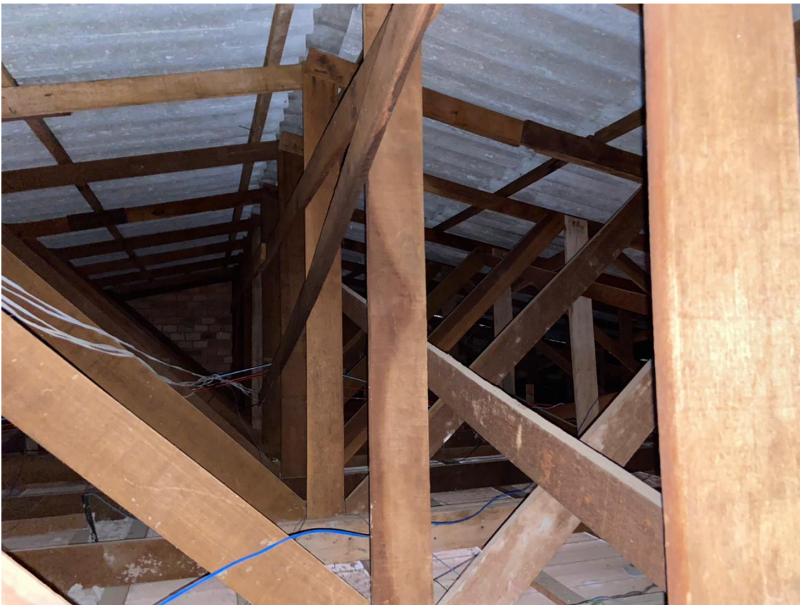
Imagem 05: Estrutura existente cobertura prédio 1.
