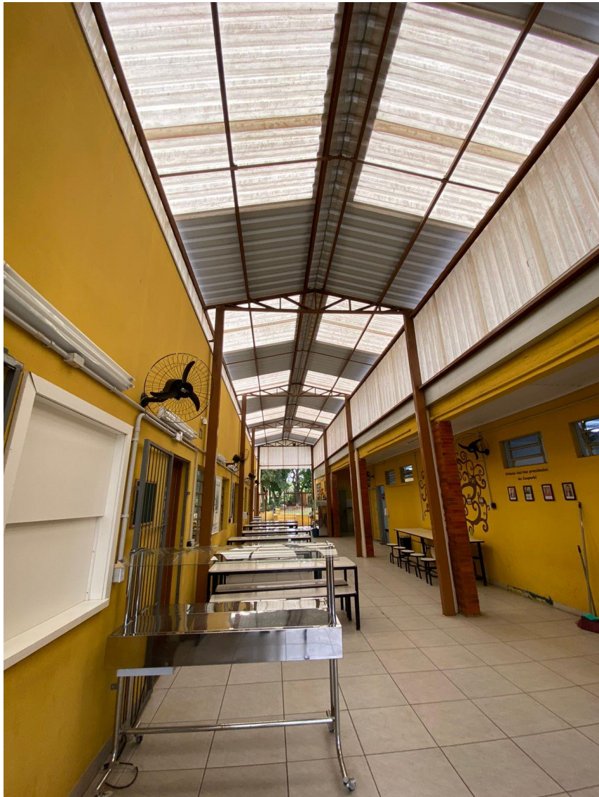
Imagem 08: Estrutura existente da cobertura do prédio 2.
