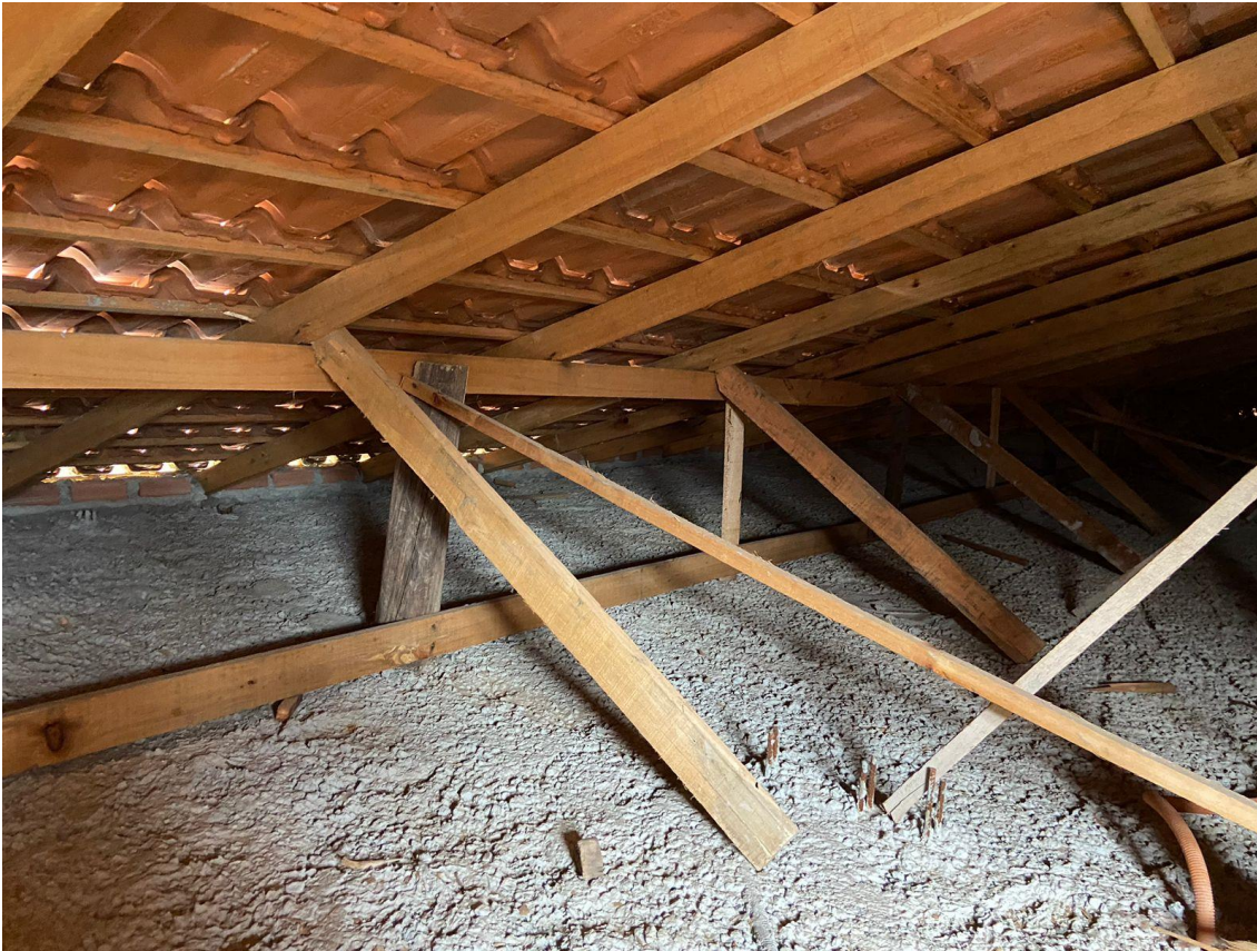
Imagem 05: Estrutura existente da cobertura do telhado.
