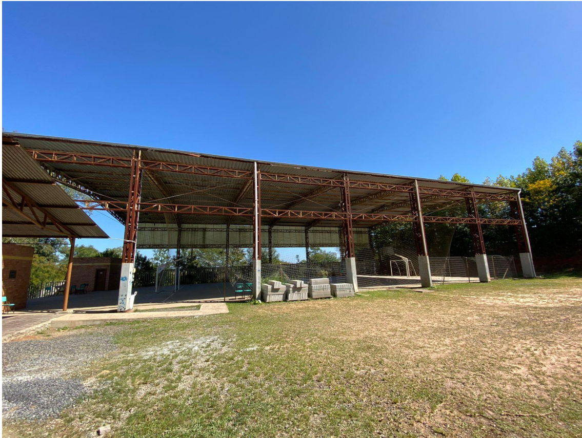
Imagem 02: Fachada do ginásio que será instalado as placas fotovoltaicas.
