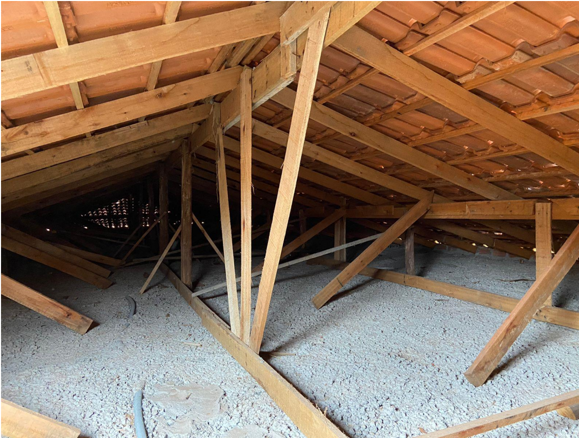
Imagem 04: Estrutura existente da cobertura do telhado.
