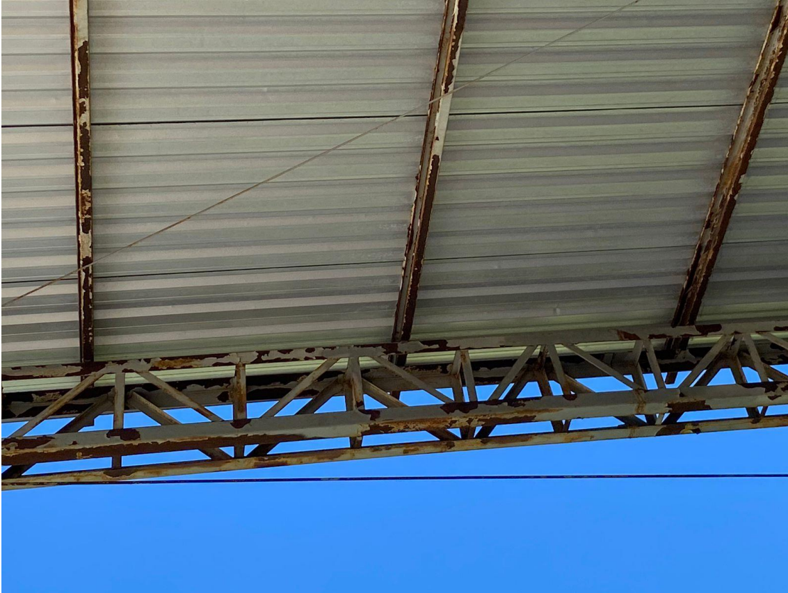
Imagem 06: Estrutura cobertura ginásio escola.
