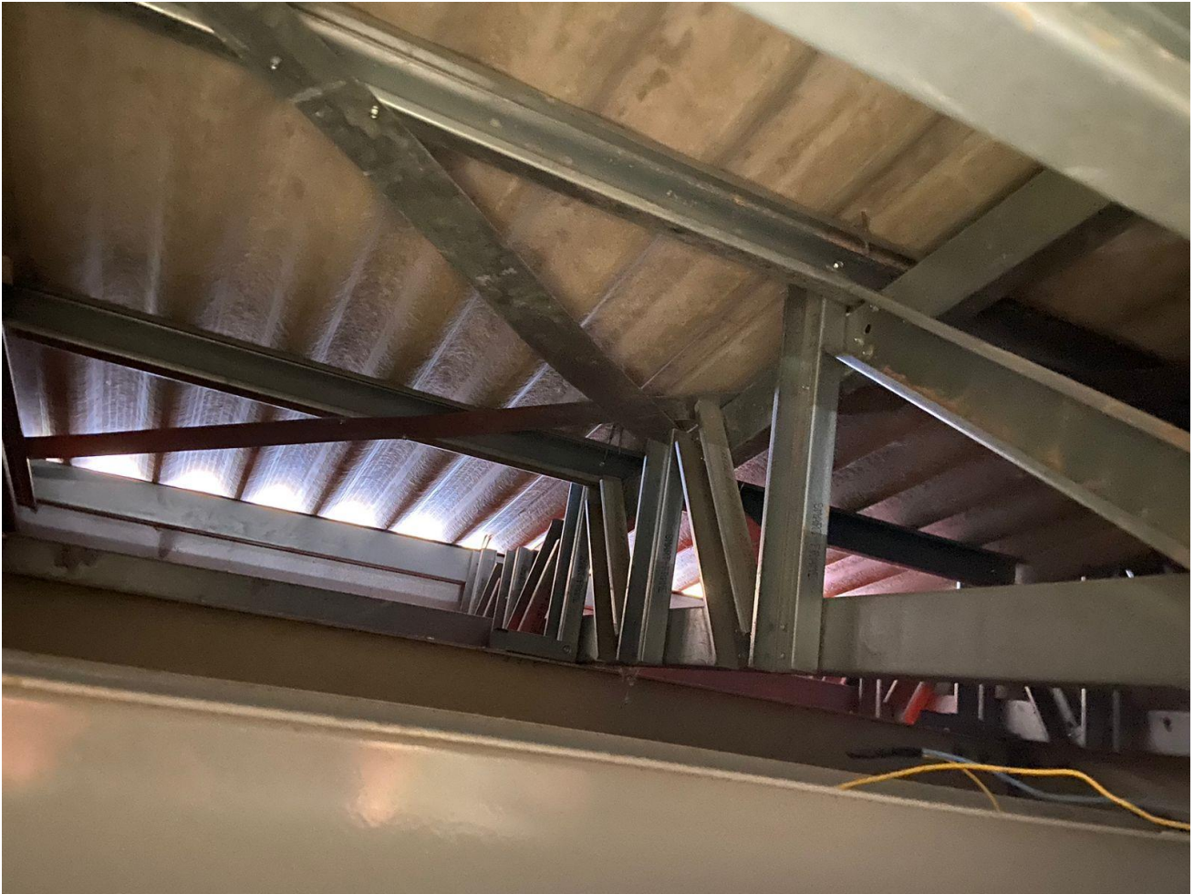
Imagem 08: Estrutura cobertura telhado.
