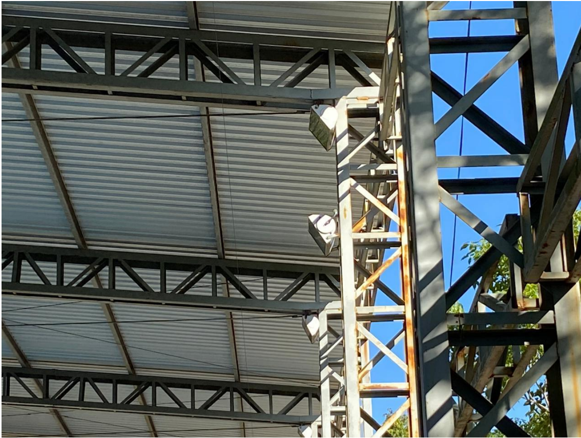
Imagem 06: Estrutura cobertura ginásio escola.
