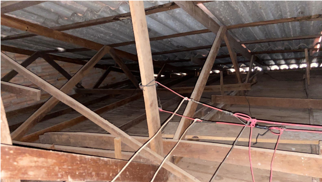
Imagem 07: Estrutura existente da cobertura do prédio 1.
