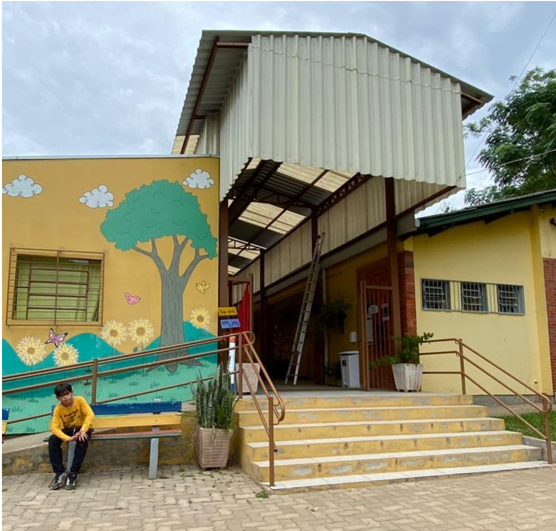
Imagem 03: Fachada do prédio 2 da escola que será instalado as placas fotovoltaicas.
