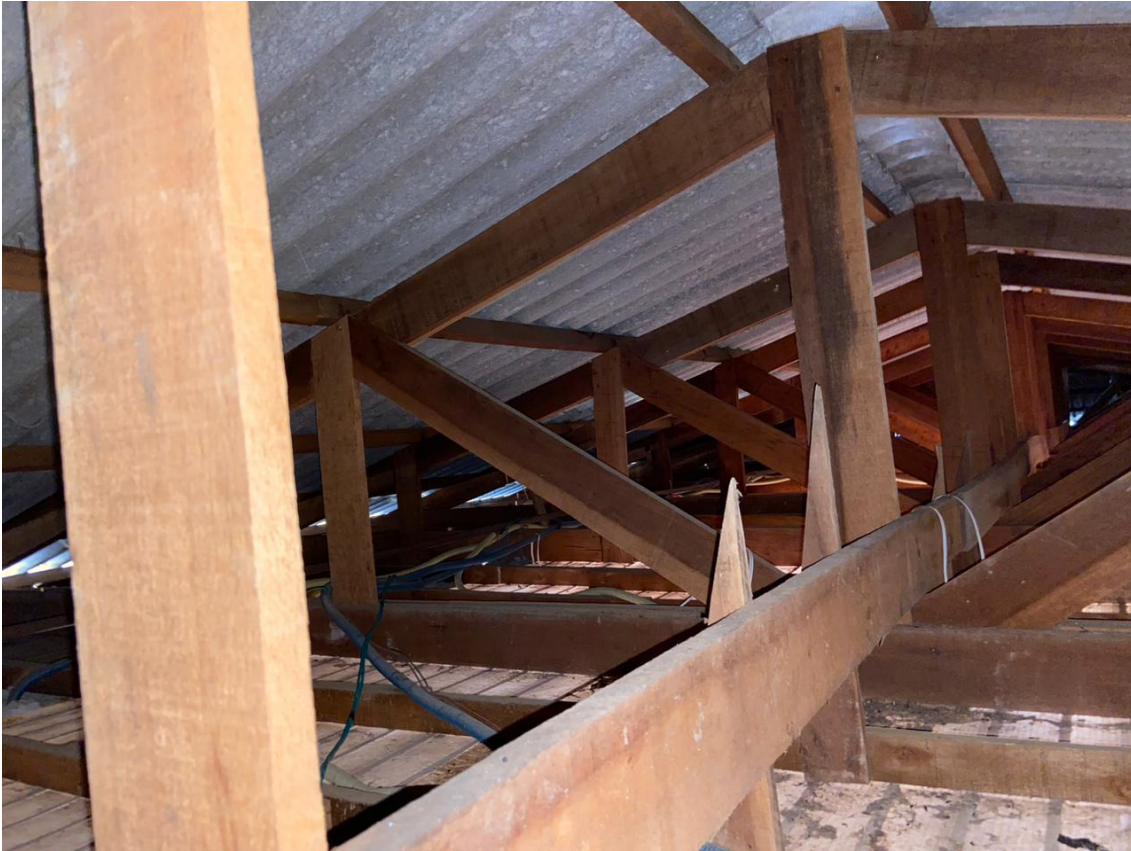
Imagem 08: Estrutura existente cobertura prédio 2.
