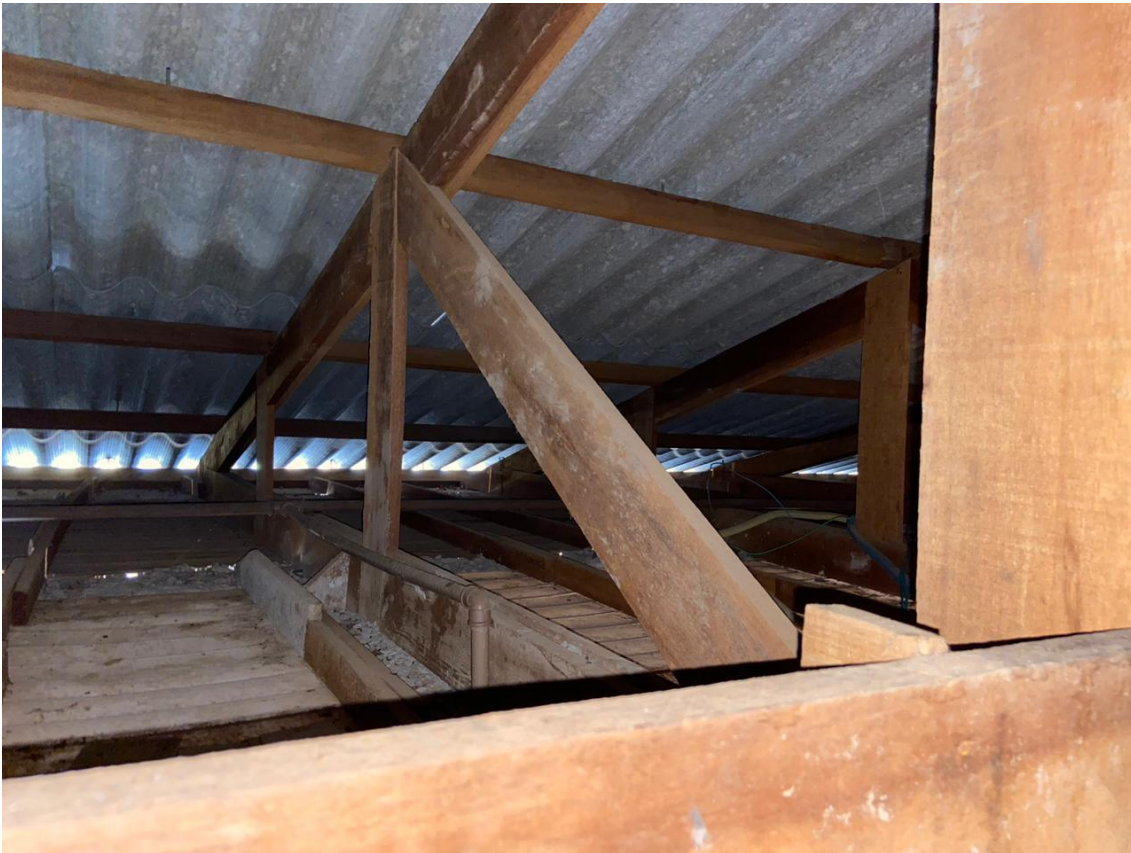
Imagem 07: Estrutura existente cobertura prédio 2.
