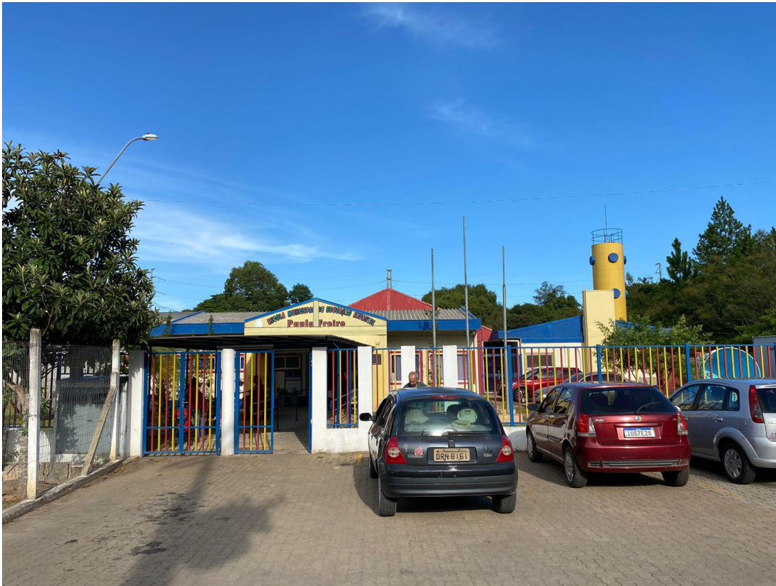
Imagem 01: Fachada da escola.
