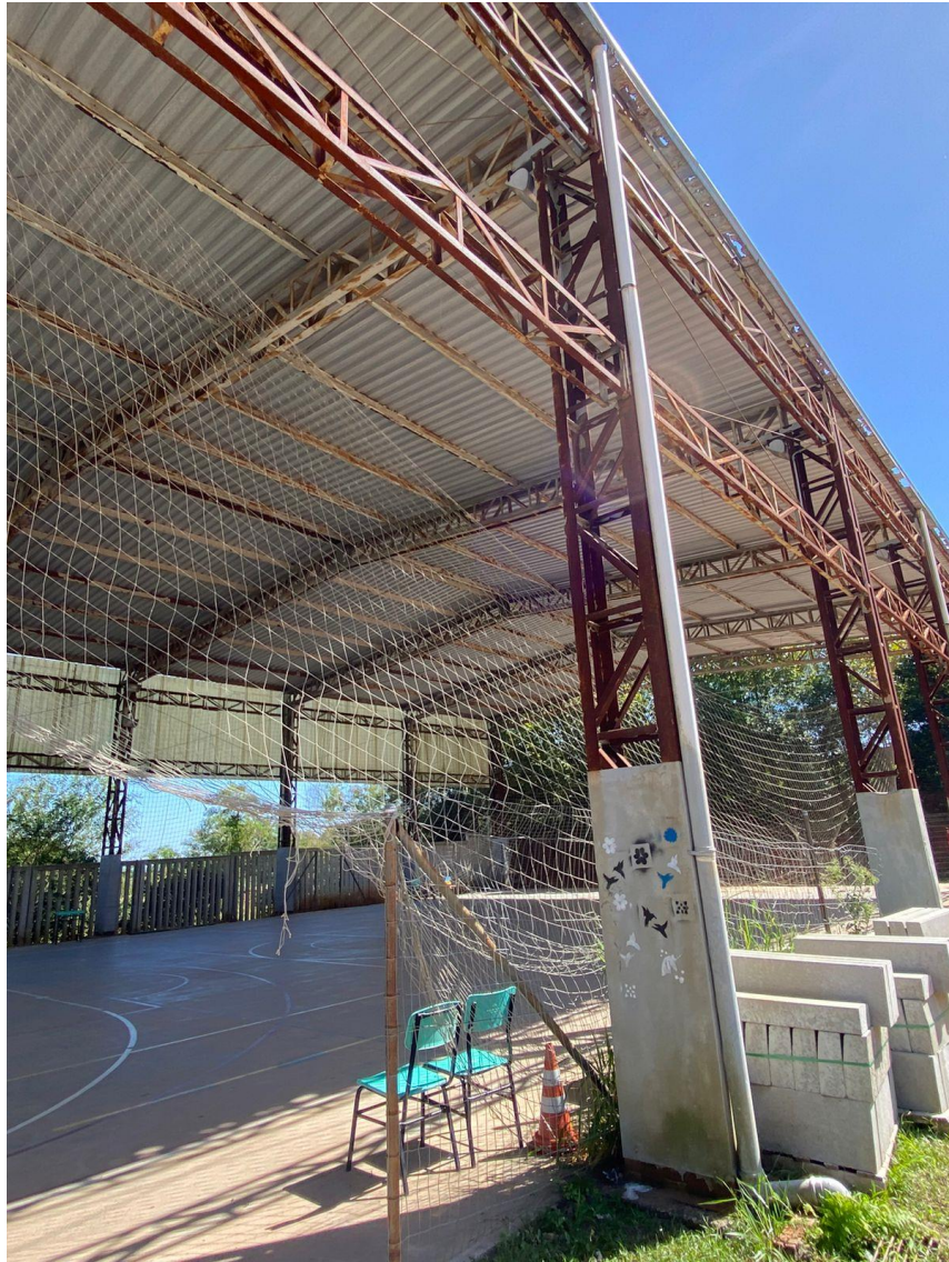
Imagem 06: Estrutura ginásio escola.
