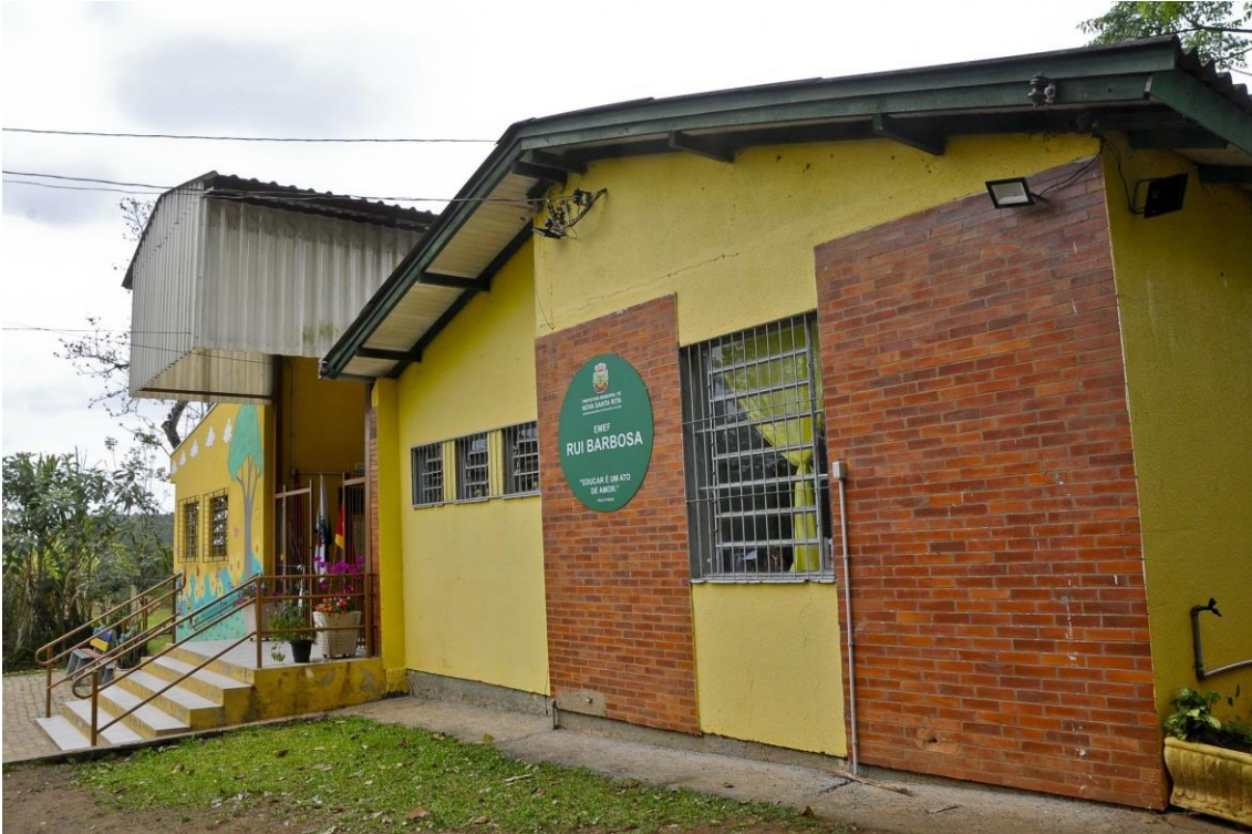
Imagem 4: Fachada do prédio 3 da escola que será instalado as placas fotovoltaicas.
