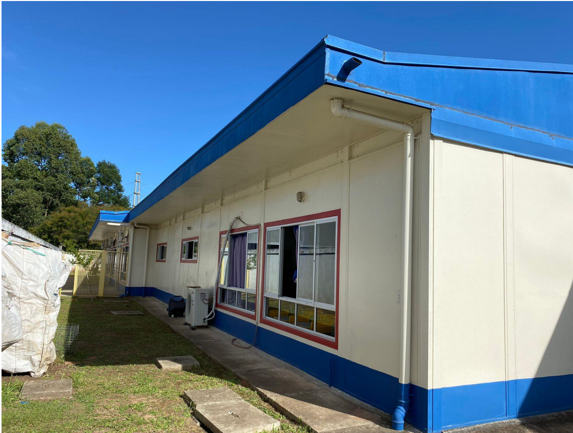
Imagem 03: Fachada prédio 3 e 4.
