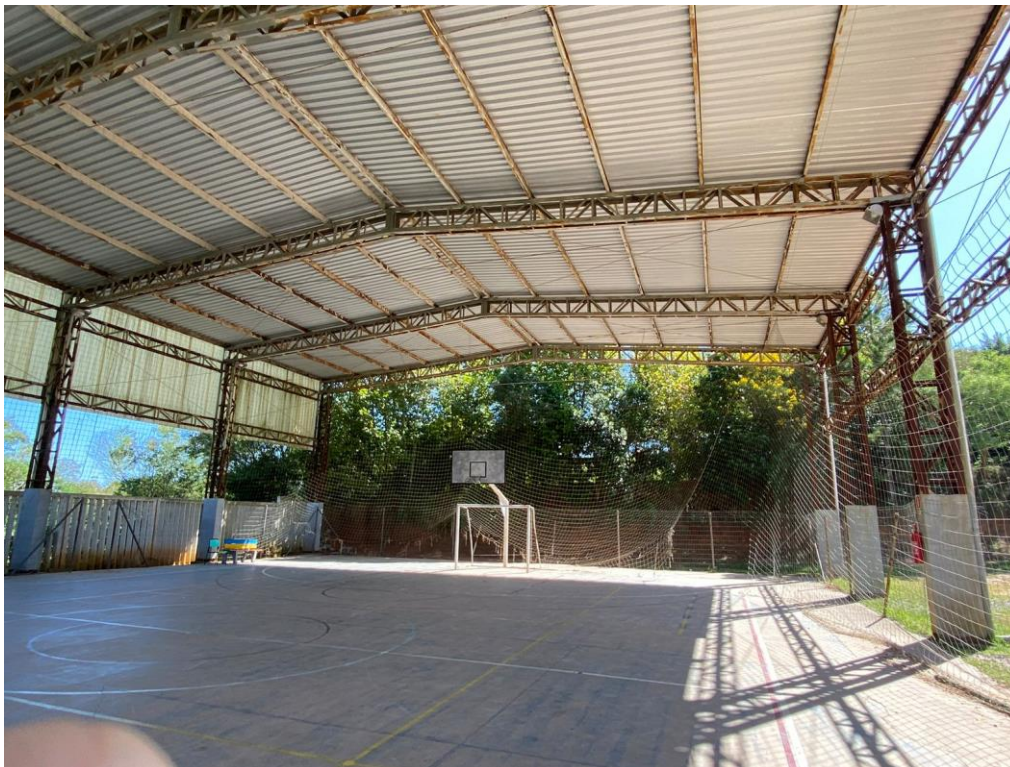
Imagem 05: Estrutura ginásio escola.
