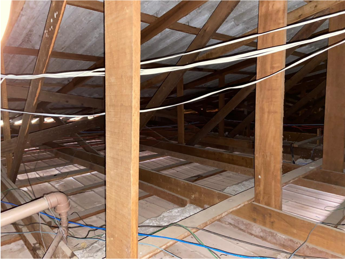
Imagem 06: Estrutura existente cobertura prédio 1.
