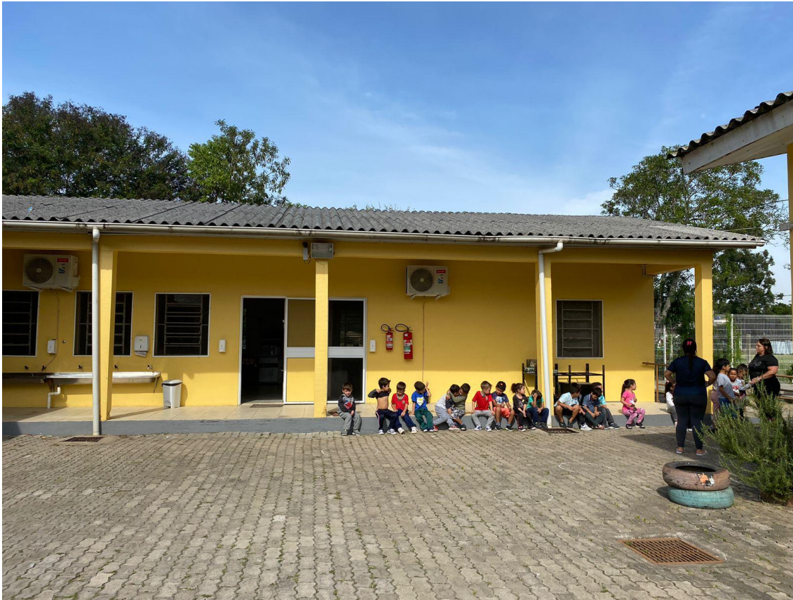
Imagem 03: Fachada do prédio 3 da escola que será instalado as placas fotovoltaicas.
