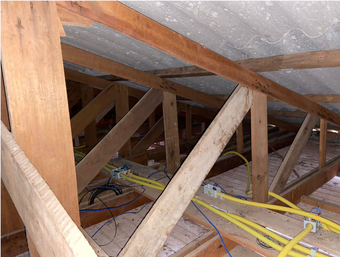
Imagem 09: Estrutura existente da cobertura do prédio 3.
