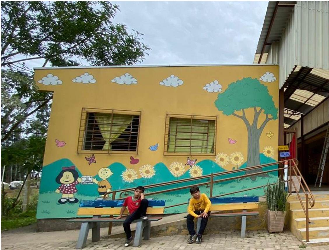
Imagem 02: Fachada do prédio 1 da escola que será instalado as placas fotovoltaicas.
