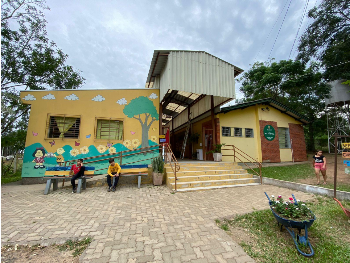
Imagem 01: Fachada da escola que será instalado as placas fotovoltaicas.
