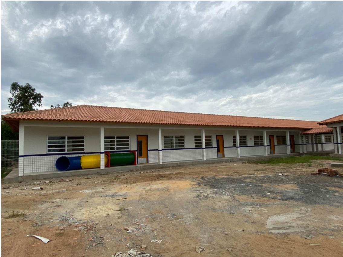
Imagem 01: Fachada do prédio da escola que será instalado as placas fotovoltaicas.
