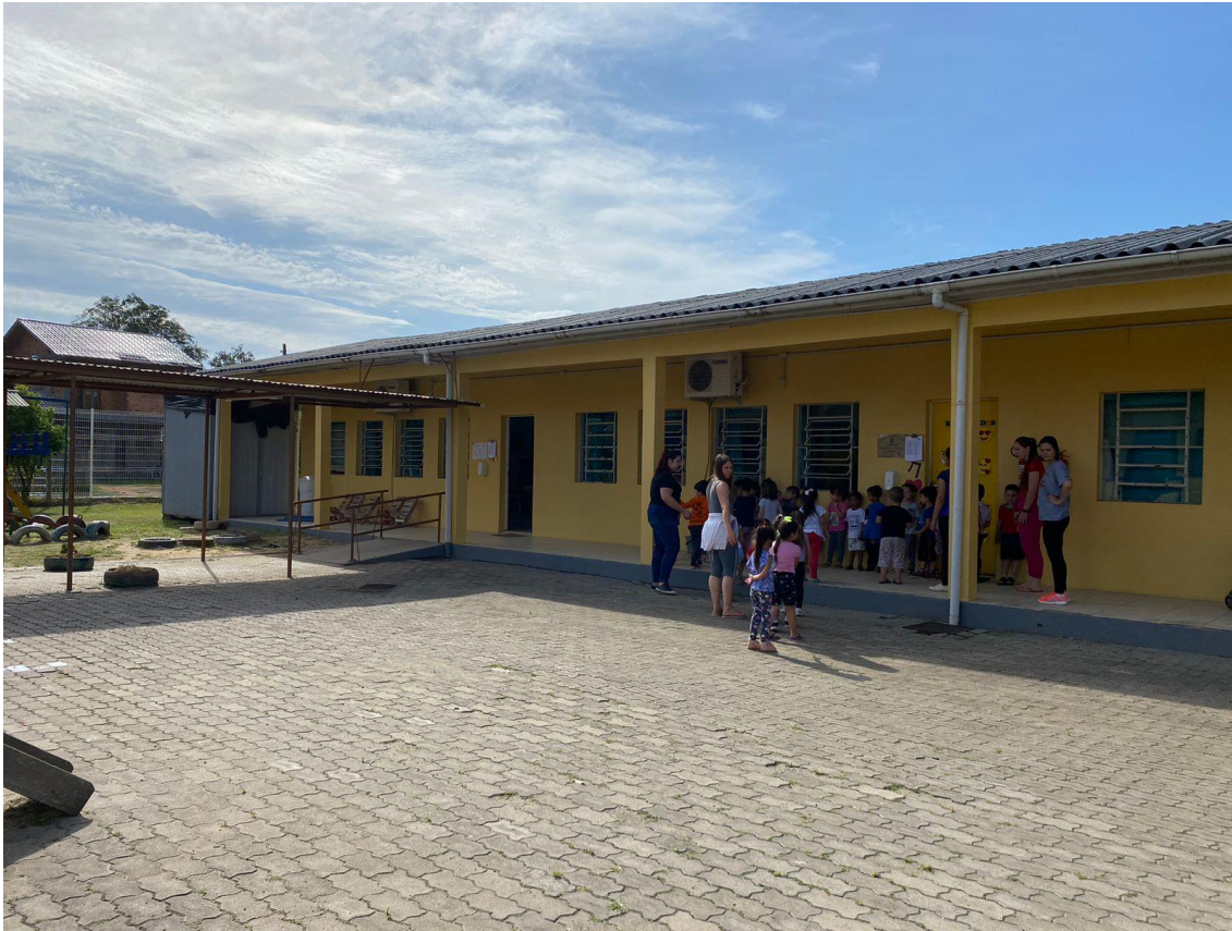
Imagem 02: Fachada do prédio 2 da escola que será instalado as placas fotovoltaicas.
