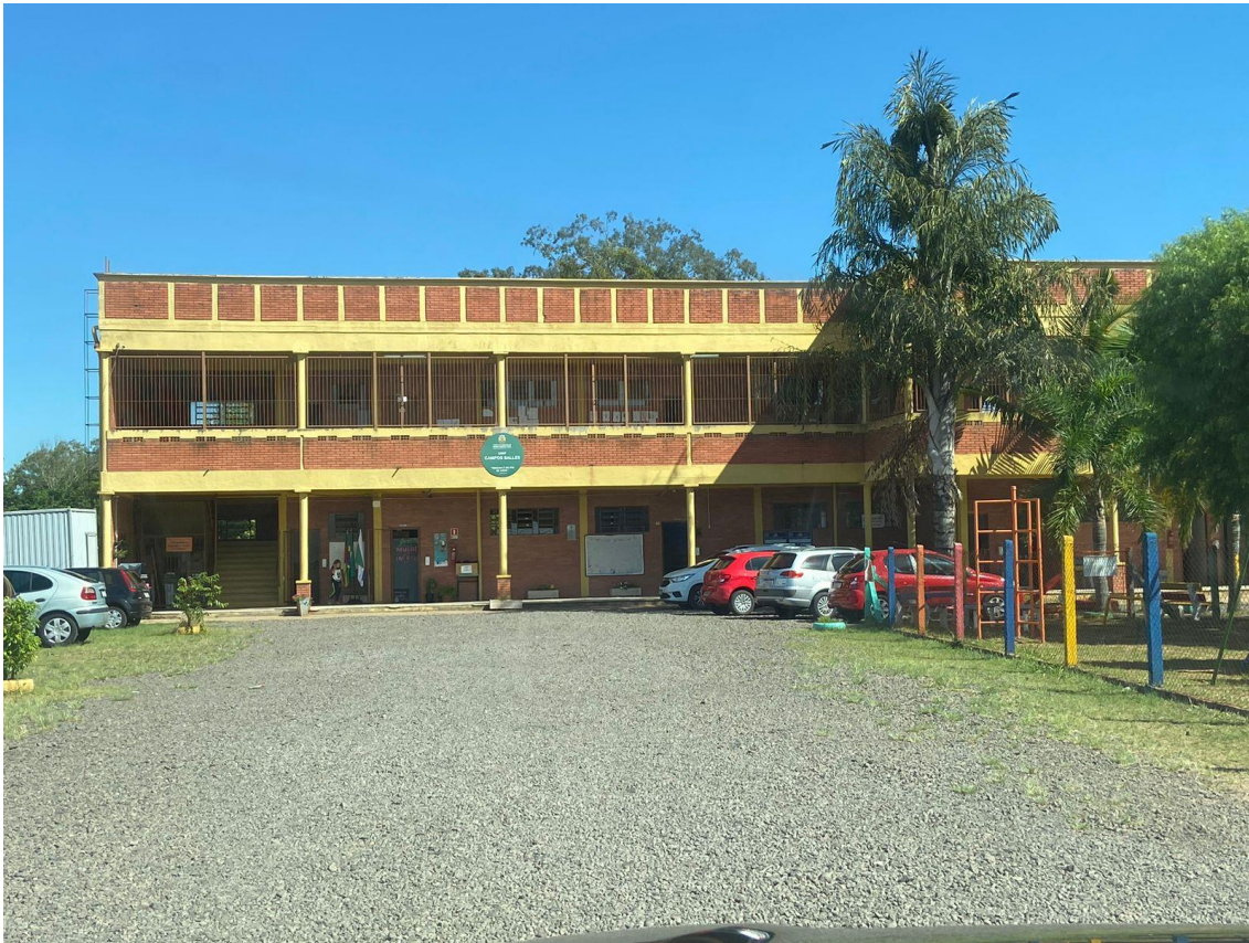
Imagem 01: Fachada da escola.
