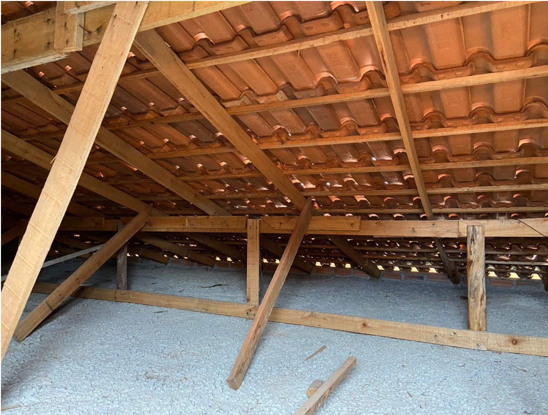
Imagem 03: Estrutura existente da cobertura do telhado.
