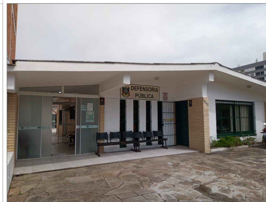
FACHADA FRONTAL - EDIFICAÇÃO FRENTE
