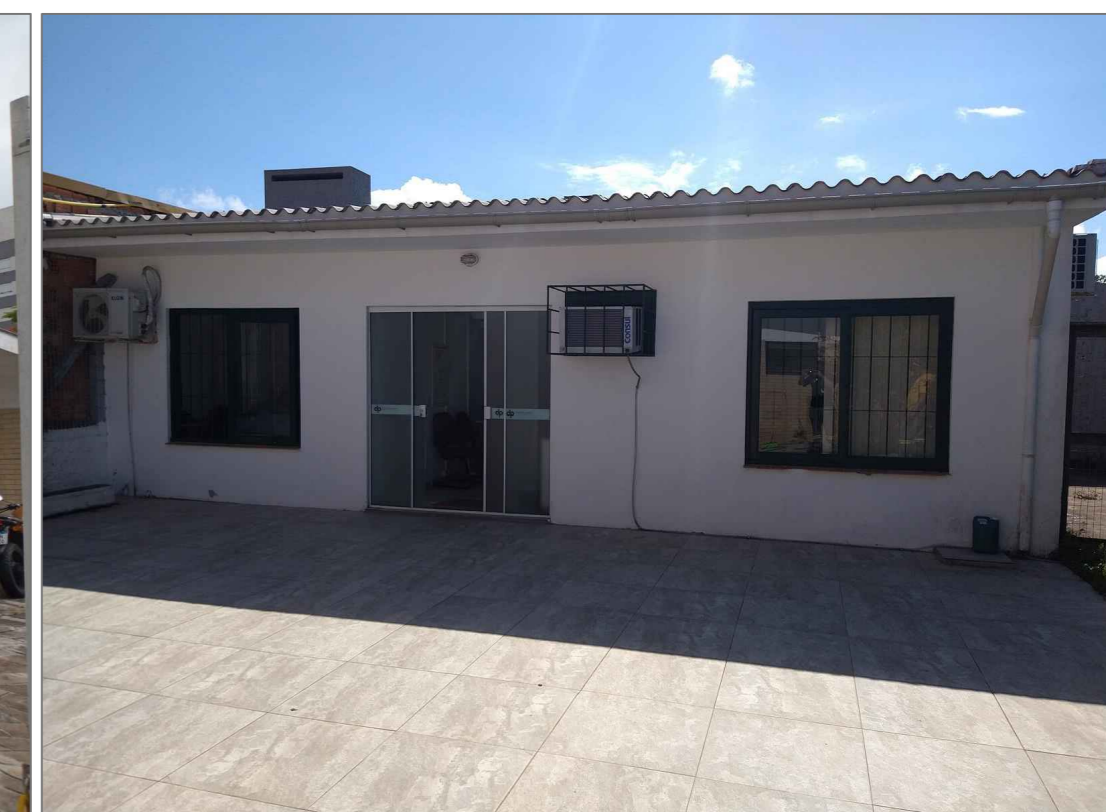
FACHADA FRONTAL - EDIFICAÇÃO FUNDOS
