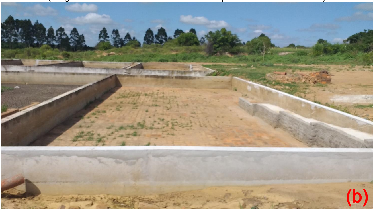
Figura 2 – Muro derrubado por veículo da CONESUL (a) antes (b) depois
