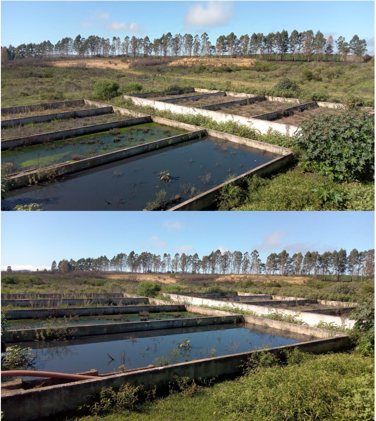
Figura 3 – Situação atual dos leitos de secagem
