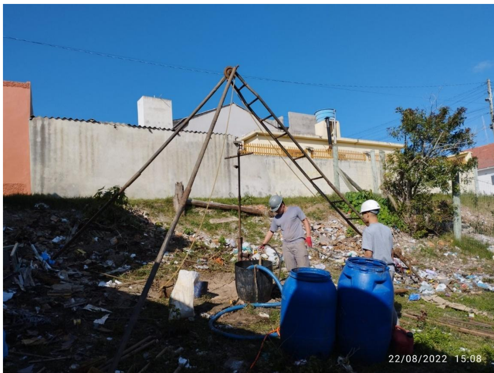
Figura 3 – Aspectos gerais da sondagem SP-01.
