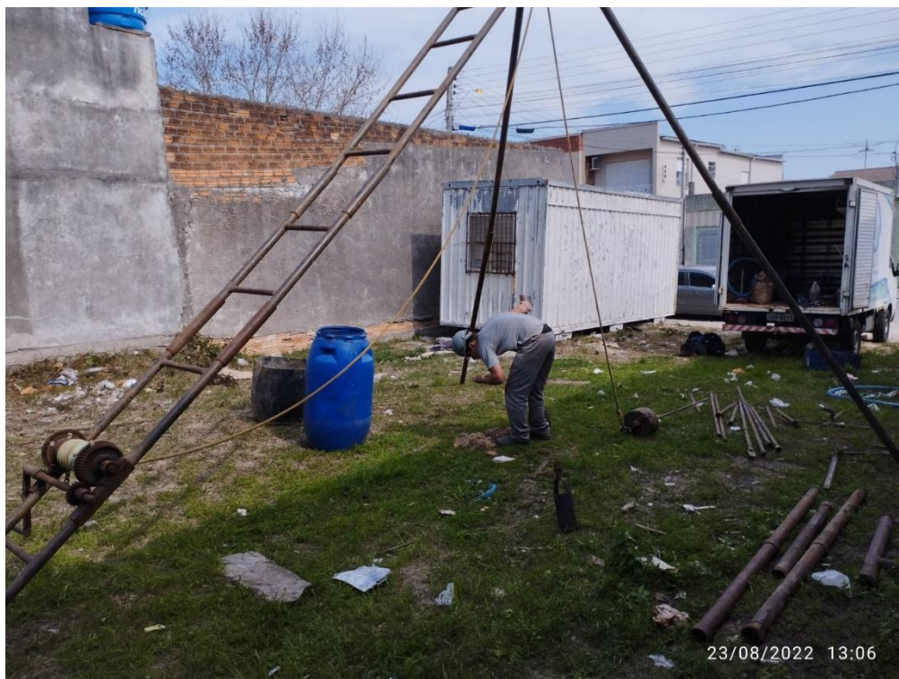
Figura 5 – Aspectos gerais da sondagem SP-02.
