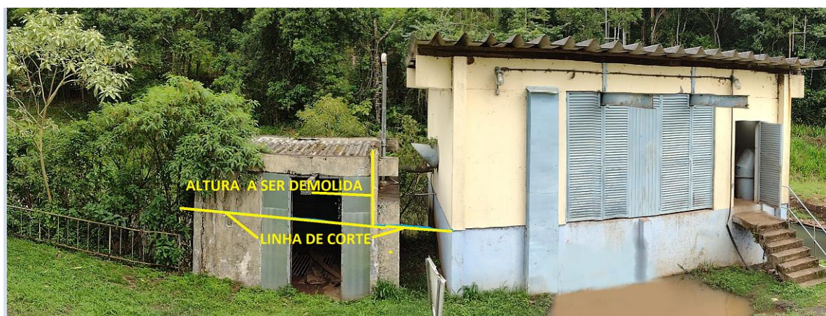
Figura 1- Vista atual casa de bombas e abrigo a ser parcialmente demolido
