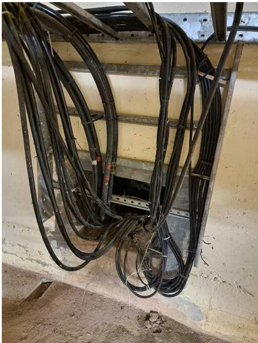
Figura 9 – Ligação de leito até o rasgo da parede para ligação a caixa de passagem existente
