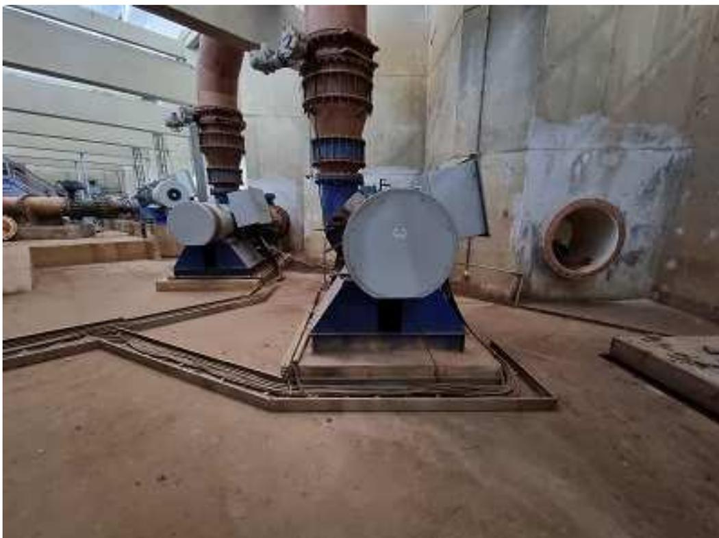
Figura 6 – Eletrovias existentes no chão e posição do novo GMB
