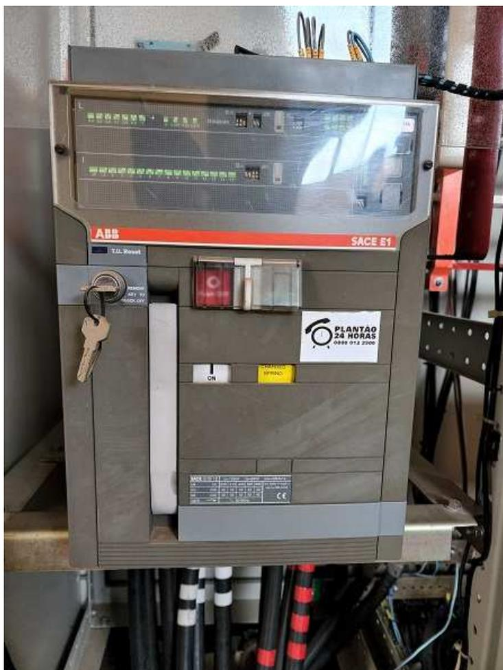
Figura 3 – Disjuntor Caixa aberta a ser substituído
