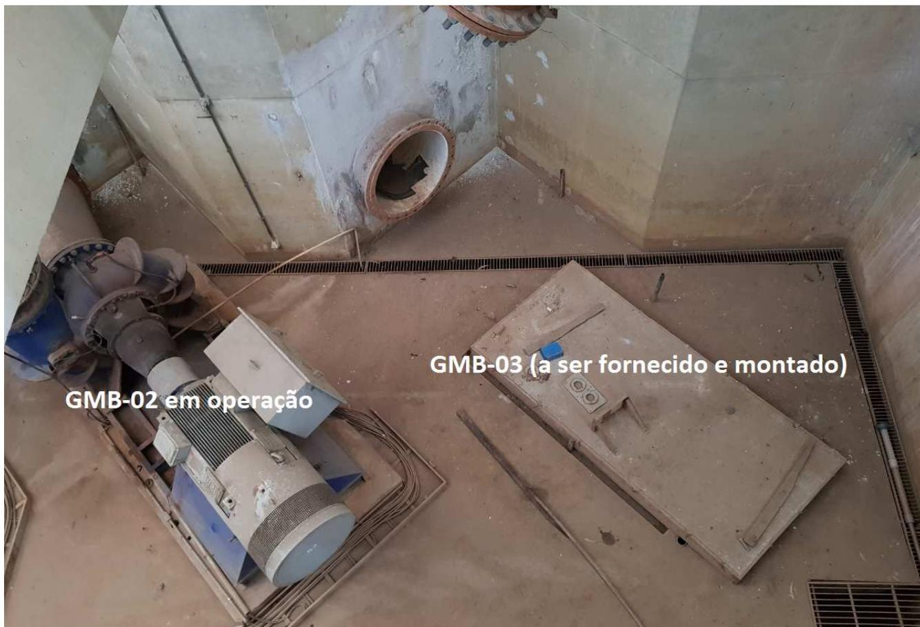
**Figura 1:** Vista em planta do local onde será montado o GMB-03
