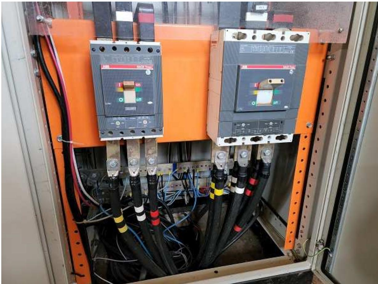
Figura 4 – Disjuntores Caixa Moldada a serem substituídos por 1 disjuntor Caixa Aberta
