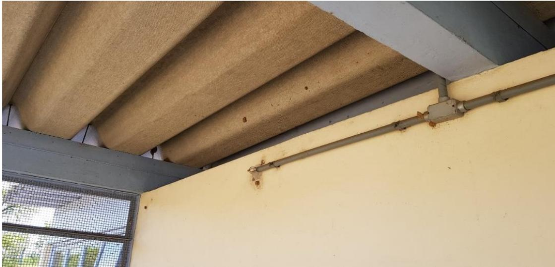
**Figura 4 Detalhe das aberturas do ambiente a serem fechadas com telha isolante térmica.**
