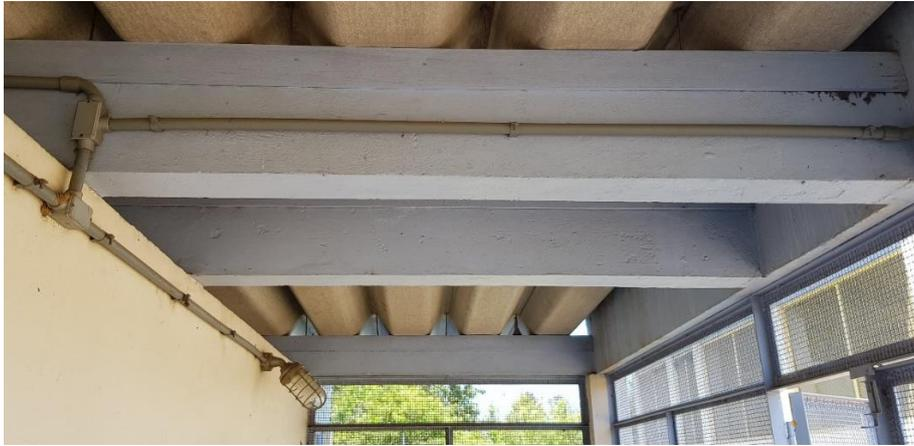
**Figura 3 Fechamento da cobertura do ambiente com nova telha reta. Remover calhetão.**
