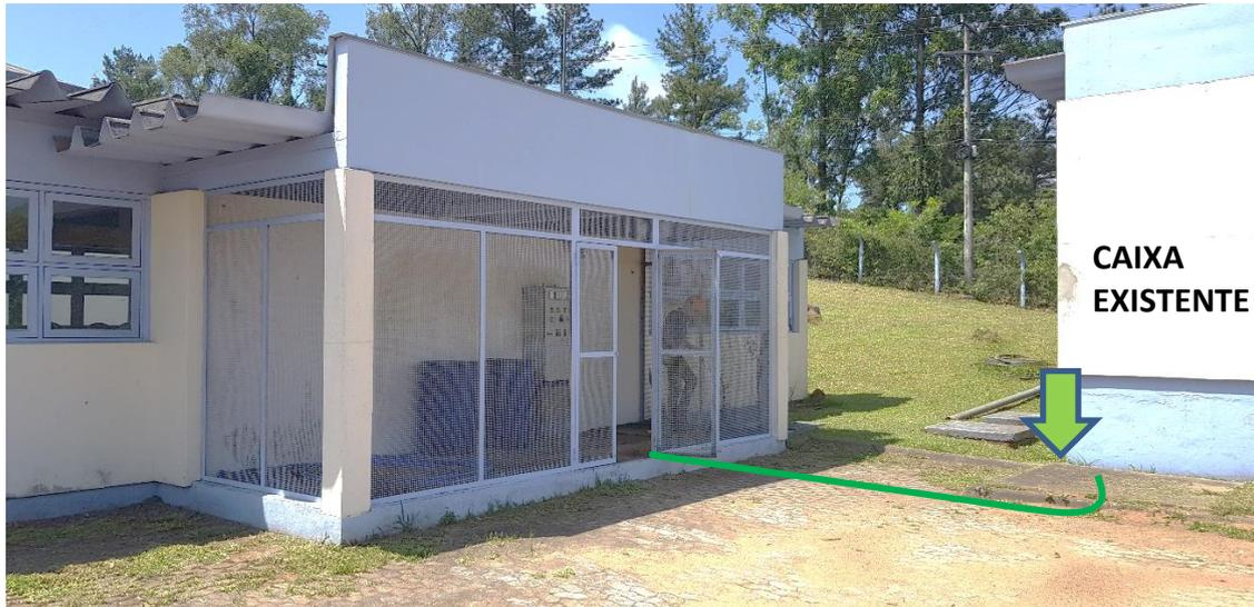
**Figura 7** Ligação do novo ramal ao QGBT aproveitando a caixa existente.
