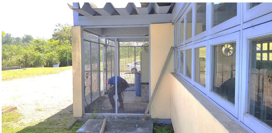
**Figura 2 Ambiente de instalação dos conversores – remover gradil, substituir por alvenaria. Remover telha calhetão substituir por telha isolante térmica.**
