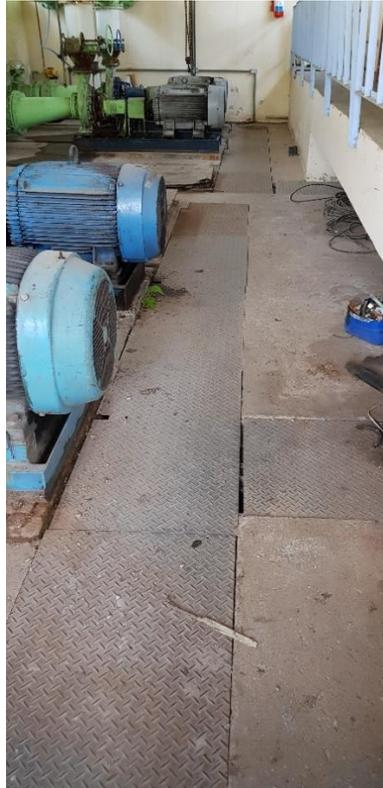
**Figura 11 Calhas de piso para passagem dos cabos.**
