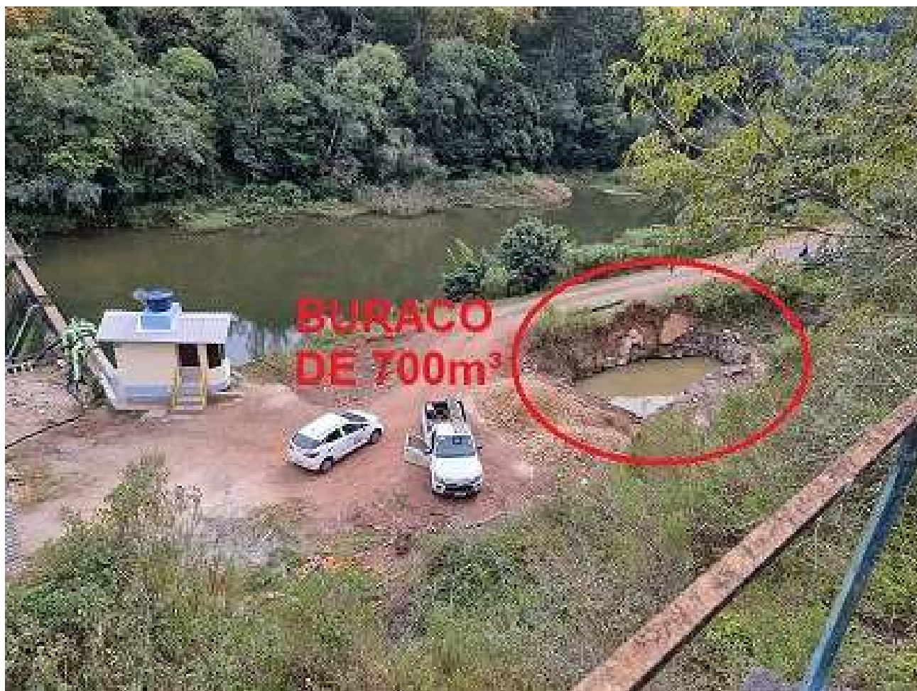
Fig. 1 – Posição do Buraco e local onde será construída a nova subestação
