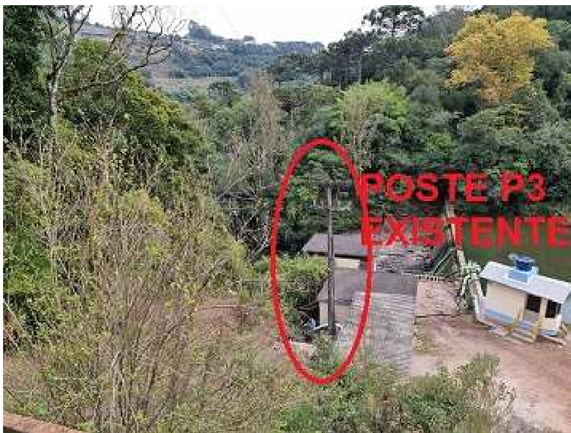
Fig. 2 – Poste P3 Existente de onde deverá partir a extensão de rede para a nova Subestação
