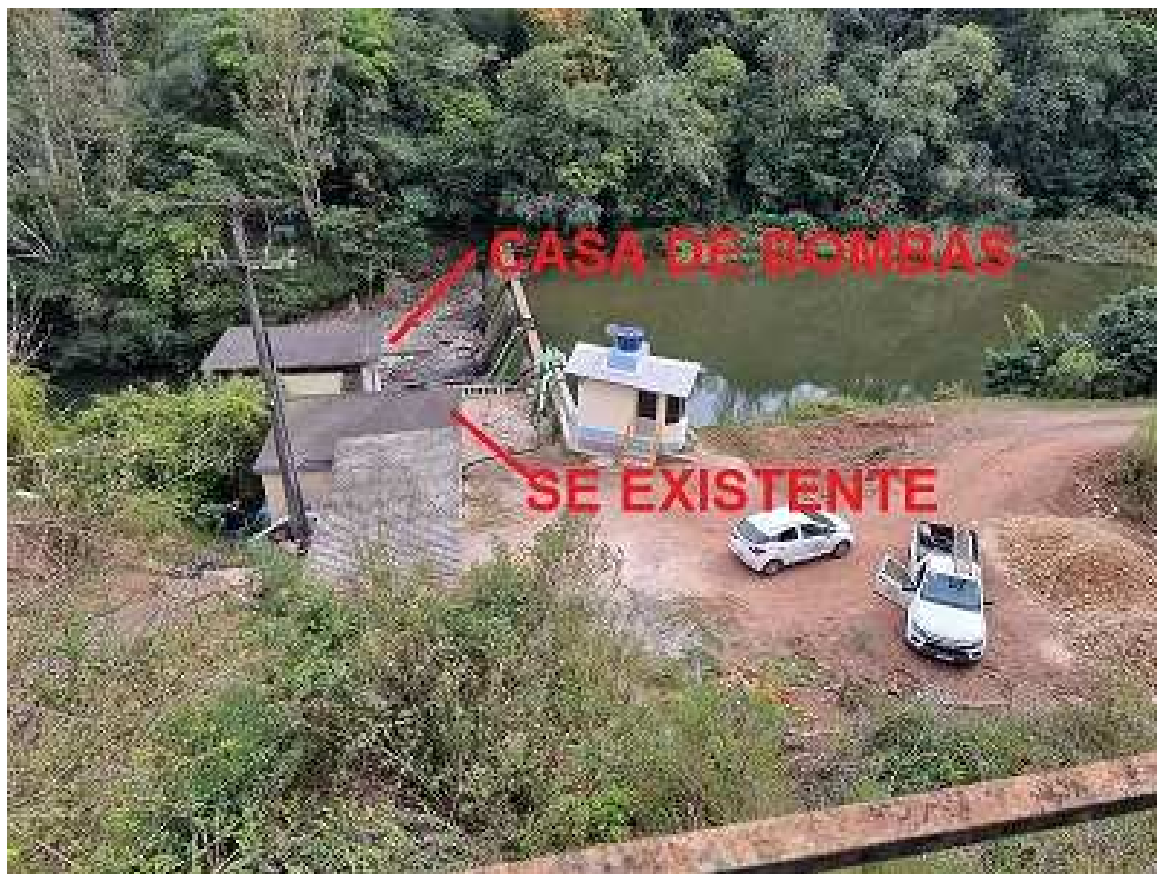
Fig. 3 – Posição da Subestação Existente onde deverá ser instalado o QGBT-3
