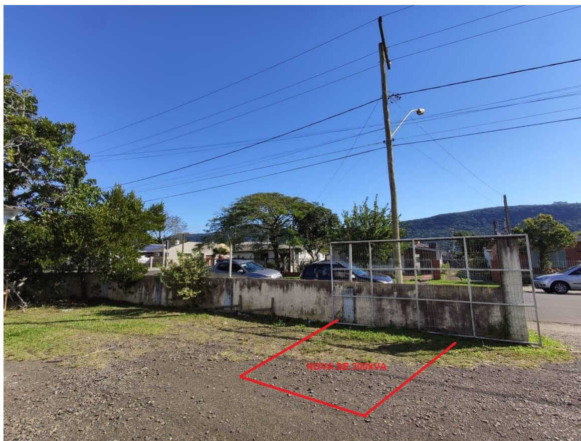
Figura 2 Local ETA Osório com destaque de instalação da nova estrutura.
