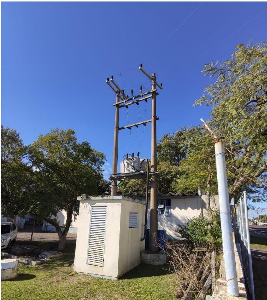
**Figura 4: Subestação existente de 150 kVA a ser desativada.**
