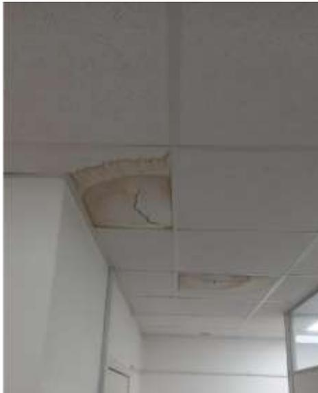
*Figura 1 – placas de forro mineral deterioradas*
