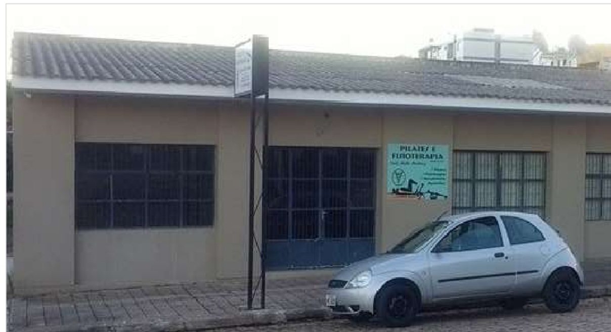
Imagem da Fachada Frontal ilustrando o posicionamento das placas existentes.
